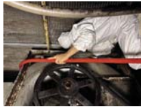
การทำความสะอาดระบบปรับอากาศ
